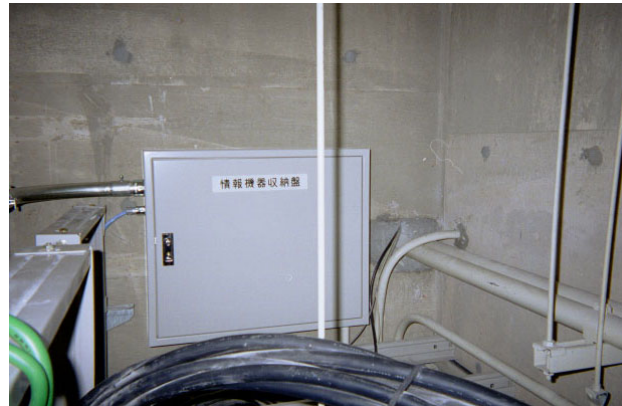
1F EPS収納盤内SW-HUB設置
