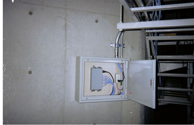
地下共同溝内SW-HUB設置
